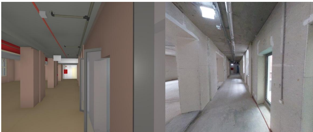
2.kép: 360° fotó és 3D modell összevetése (forrás: Swietelsky)
