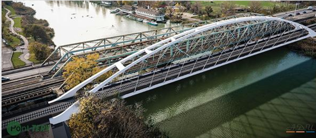
Gubacsi vasúti híd korszerűsítése fejlesztése (225kN)
