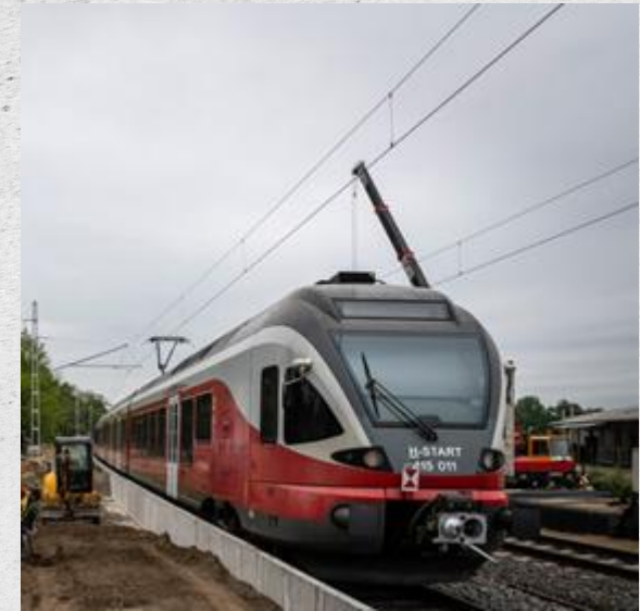
Kőbánya-Kispest – Dabas – Lajosmizse – Kecskemét vasútvonal villamosítása és elővárosi fejlesztése
