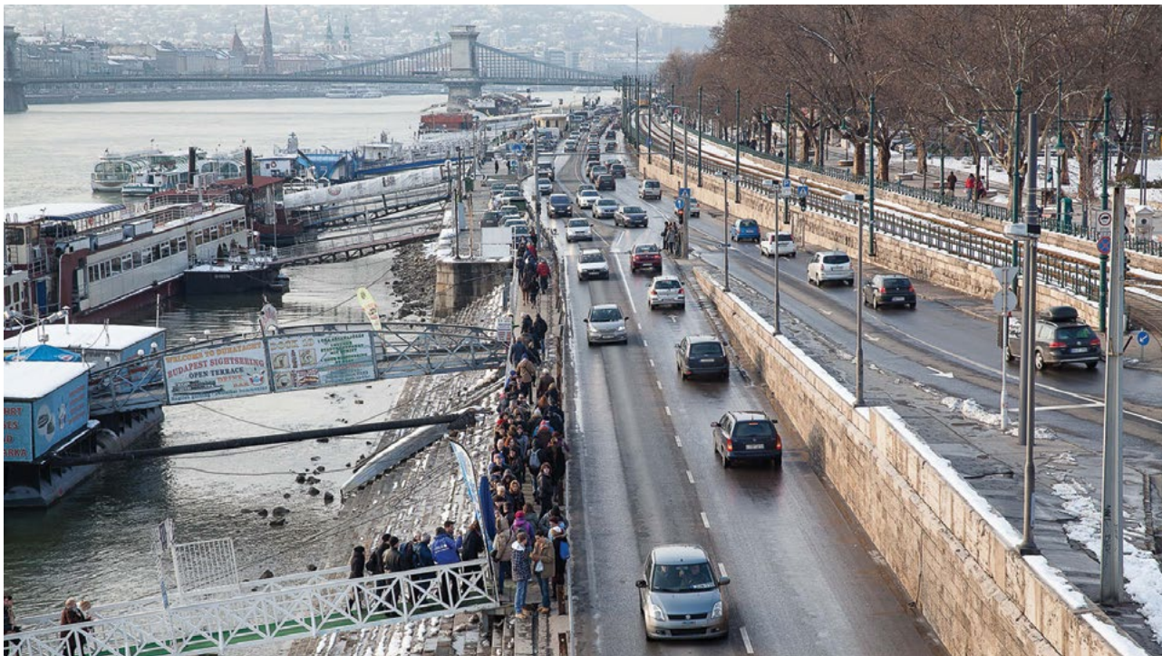
4. ábra: Pesti alsó rakpart jelenlegi állapota (Fotó: Közlekedés Kft.)
