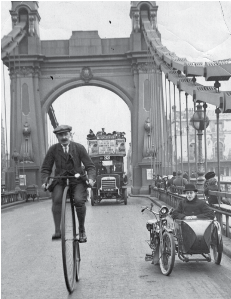
Hammersmith Bridge (1825–), London. 250 méter hosszú. Tervezte William Tierney Clark. Forgalom 1900 körül. Bereczky Ákos okl. építőmérnök szemléltető fényképe.
