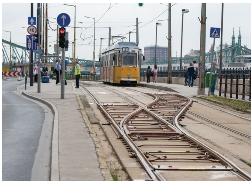
4. kép A 2-es villamos ideiglenes váltója (Forrás: BKK)
