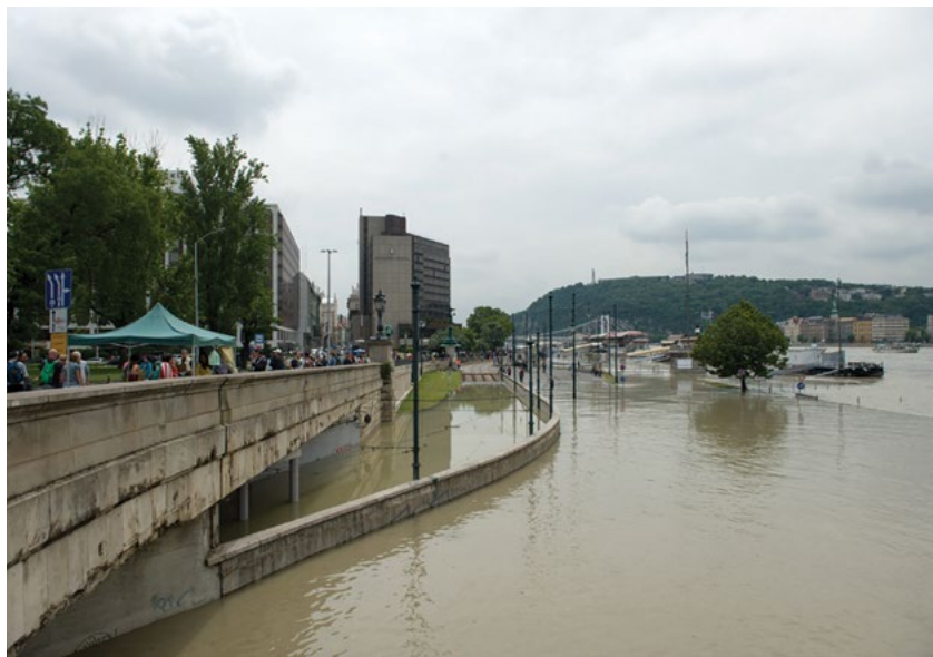
3. kép A lánchídi aluljáró elöntése (Forrás: BKK)
