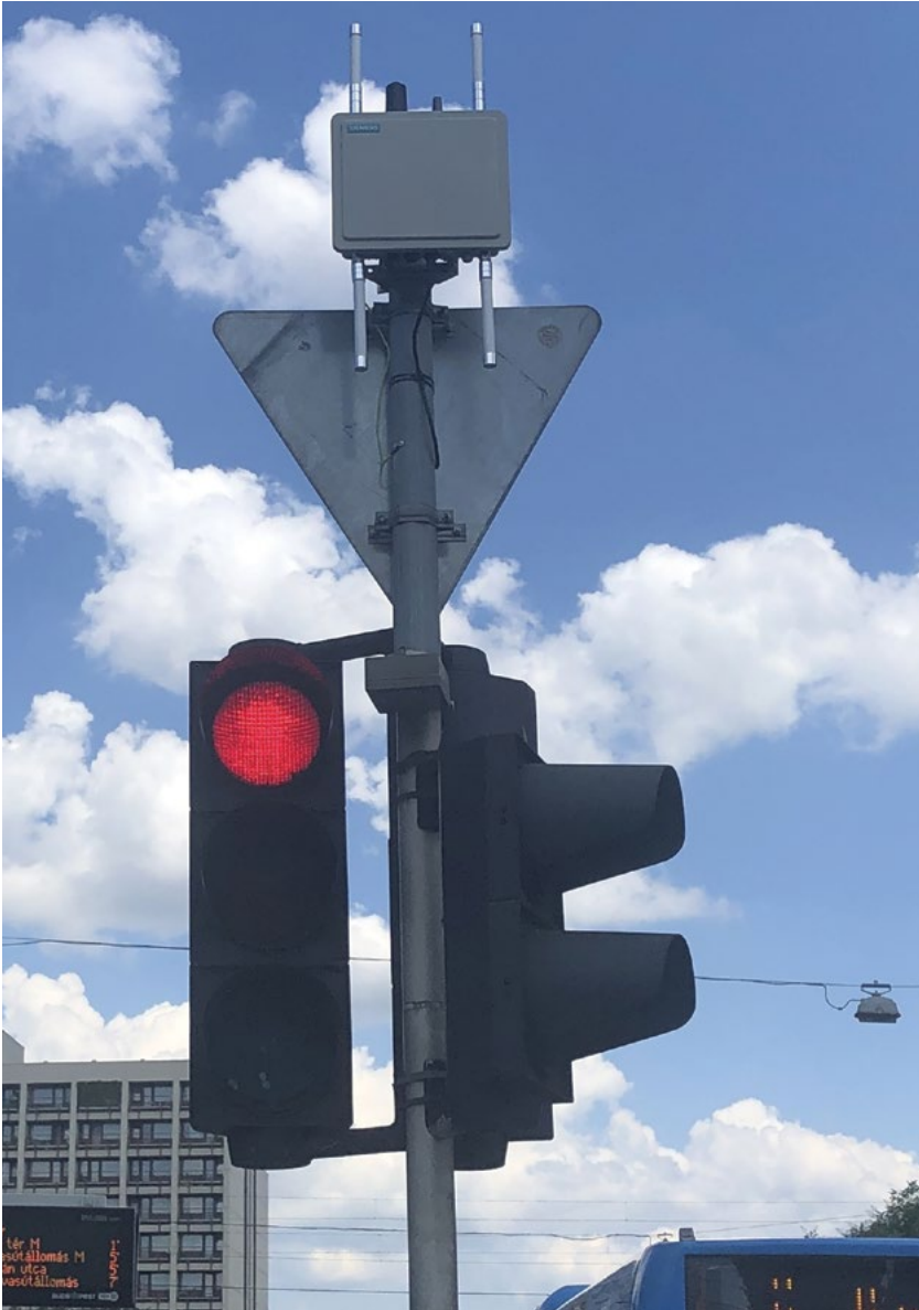
5. ábra: Budapest Közút Zrt. Hungária krt.–Thököly út csomópontban telepített Car2X szenzora (forrás: Budapest Közút Zrt.)
