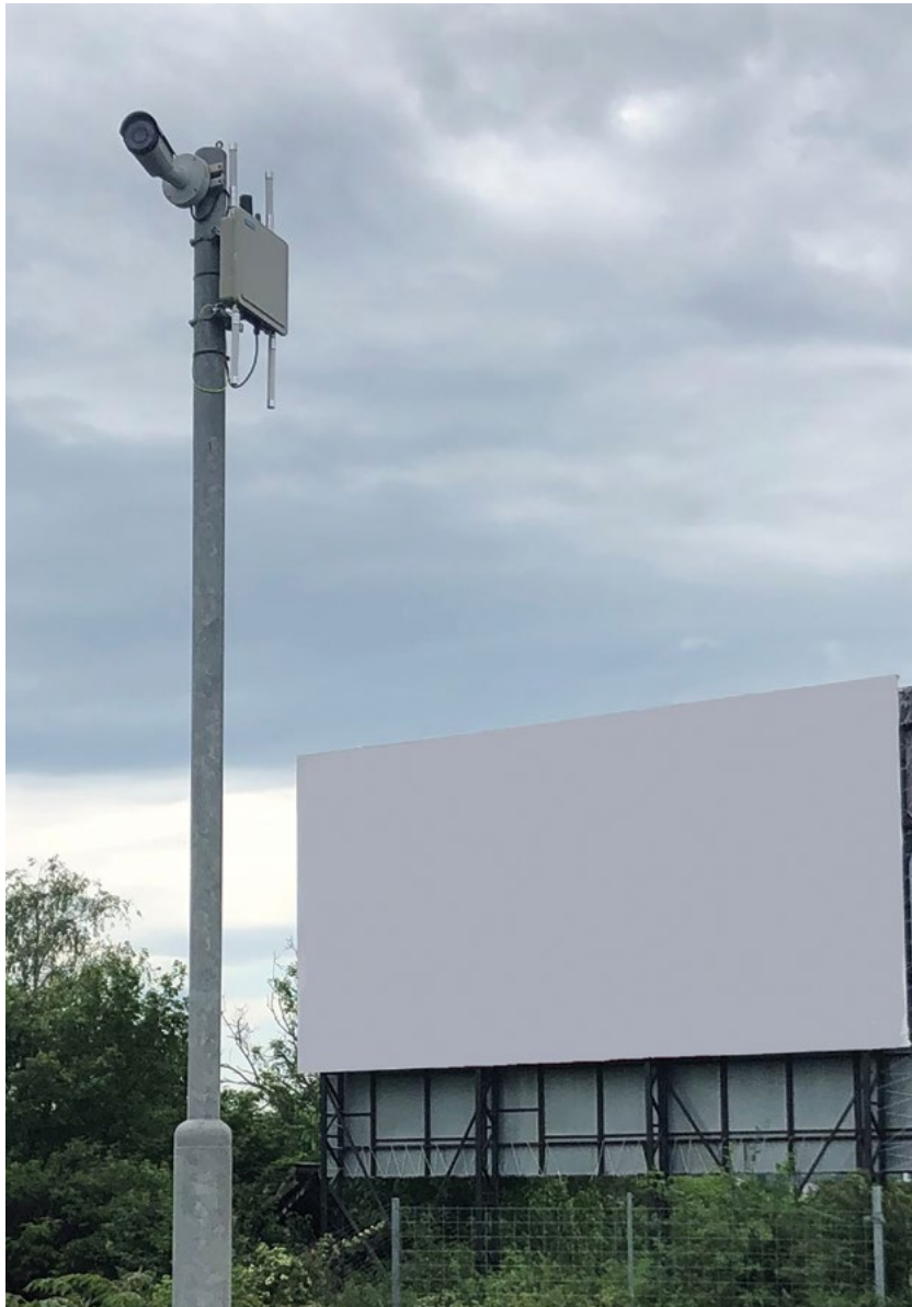
4. ábra: Budapest Közút Zrt. M1–M7 bevezetőn telepített folyópályás Car2X szenzora (forrás: Budapest Közút Zrt.)
