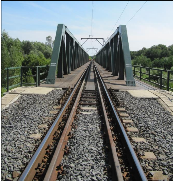
A Nagy-Rába vasúti híd a Porpác – Szentgotthárd vasútvonalon
