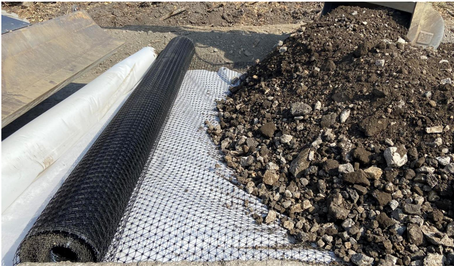
Textília + rács terítés. GRK-4 + TX 150/150
