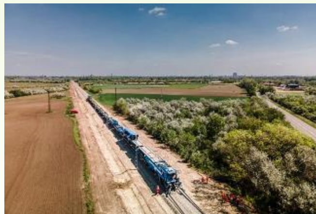
Szeged-Röszke villamosítása + deltavágány építése 2025-ig.
