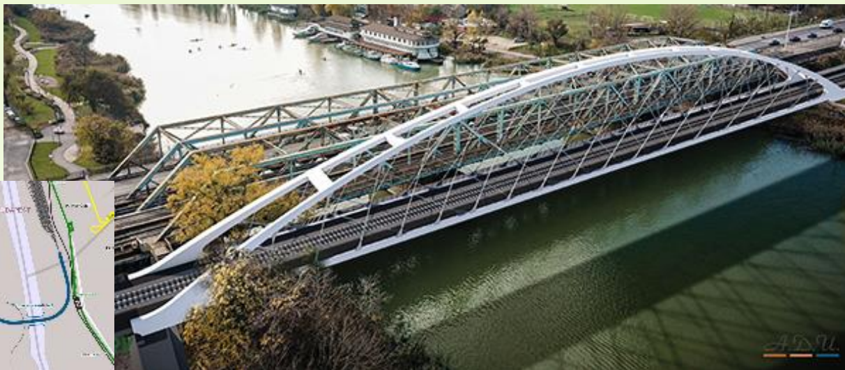
Gubacsi vasúti híd korszerűsítése.
