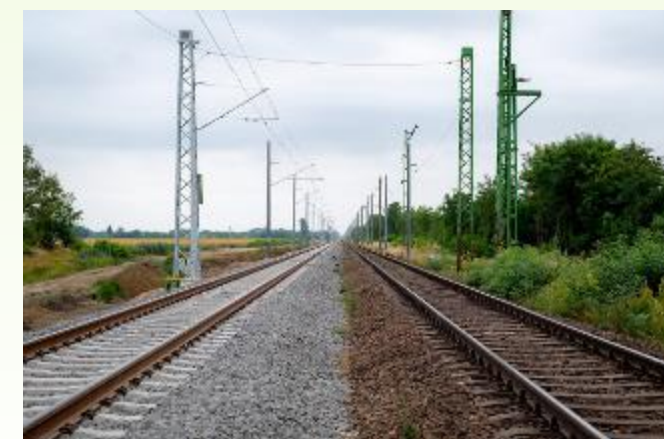
Békéscsaba-Lőkösháza vasútvonal fejlesztése 2026-ig.
