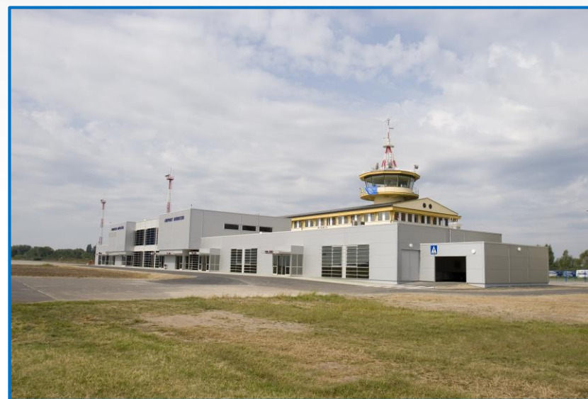
A 'C' épület építése és elkészülte 2006-ban
