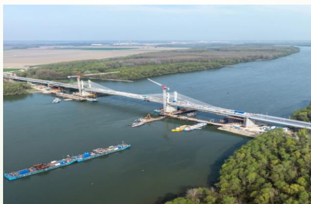
Kalocsa - Paks Duna - híd 2024 nyár
