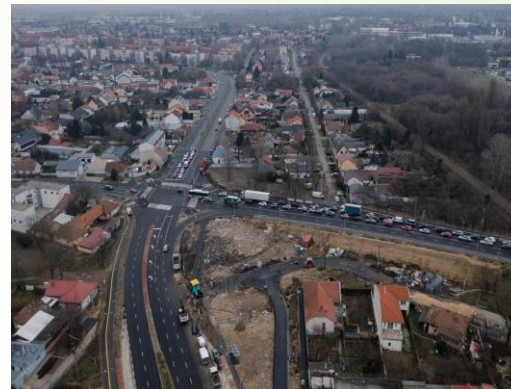
Nyíregyháza, Nagykörút délnyugati szakaszának négysávosítása
