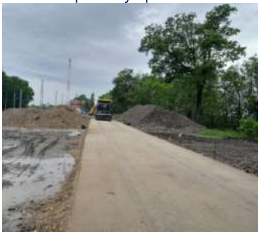
Üzemi utak építése
