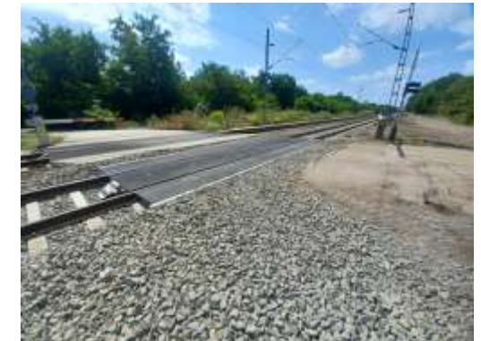
AS 1443 útátjáró aszfaltozás előtt
