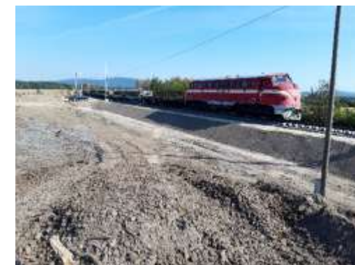
Vágányszakaszok szállítása és fektetése
