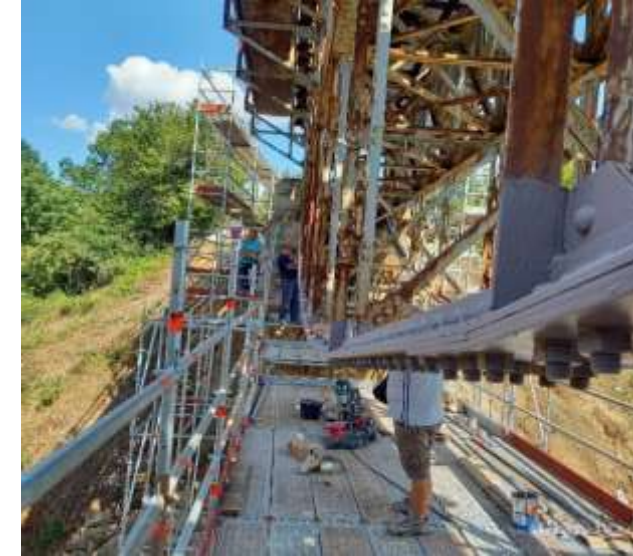
Alsó feszítőmű megerősítése (II. viadukt)
