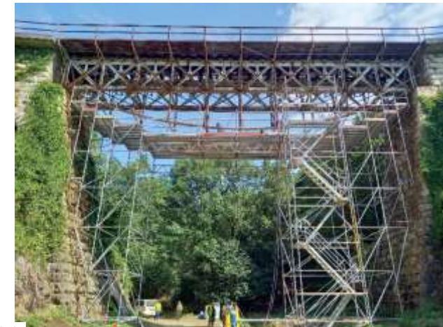
Beállványozott szerkezet (I. viadukt)
