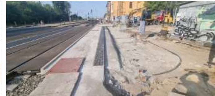
Bizber, csatorna, és víznyelő rács építése
