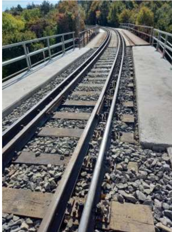
A csatlakozó és a hídon lévő elkészült pálya (II. viadukt)
