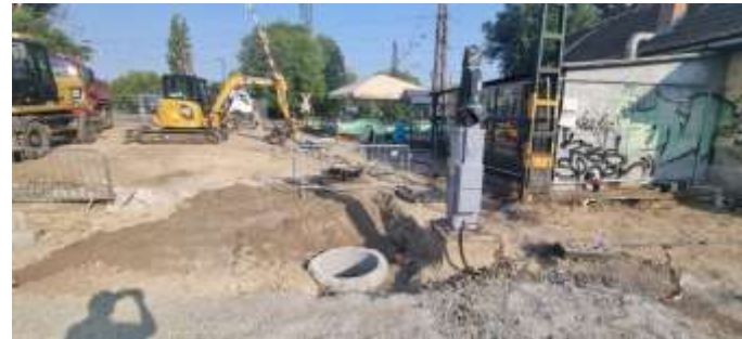
Szegedi úti átjáró kivitelezése
