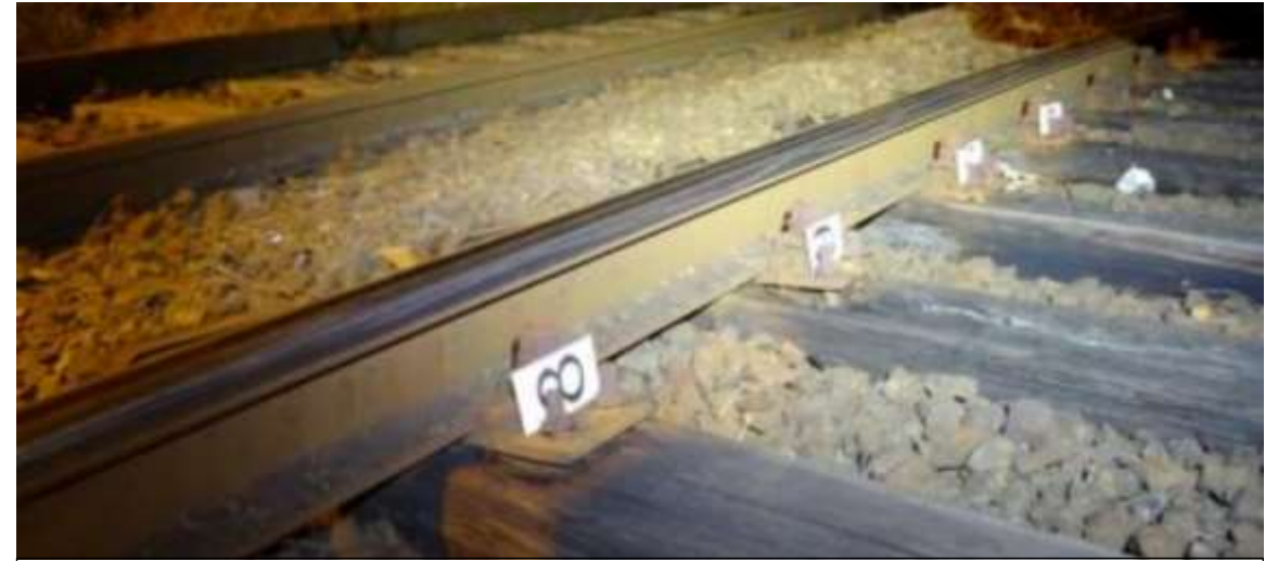
A kapcsolószerkezetek állapota siklás után [30]
