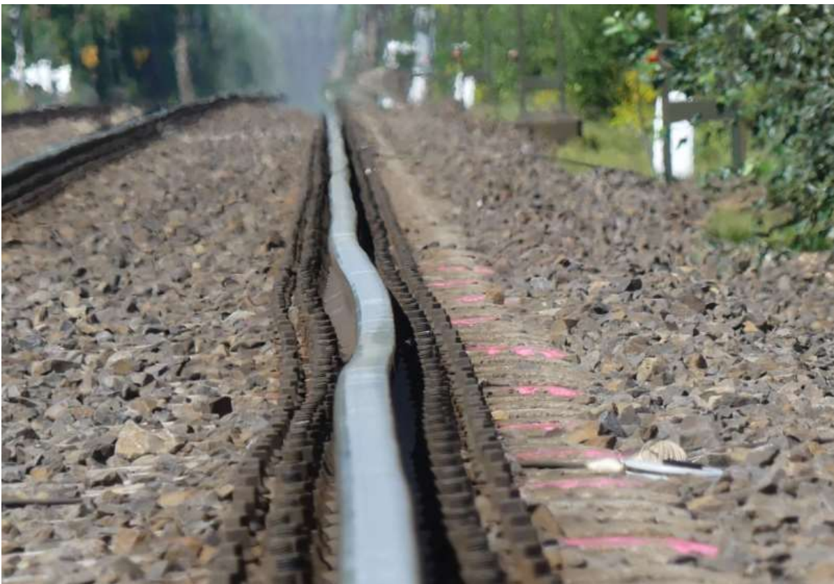
Vágánygeometriai hiba a jobb vágányban
