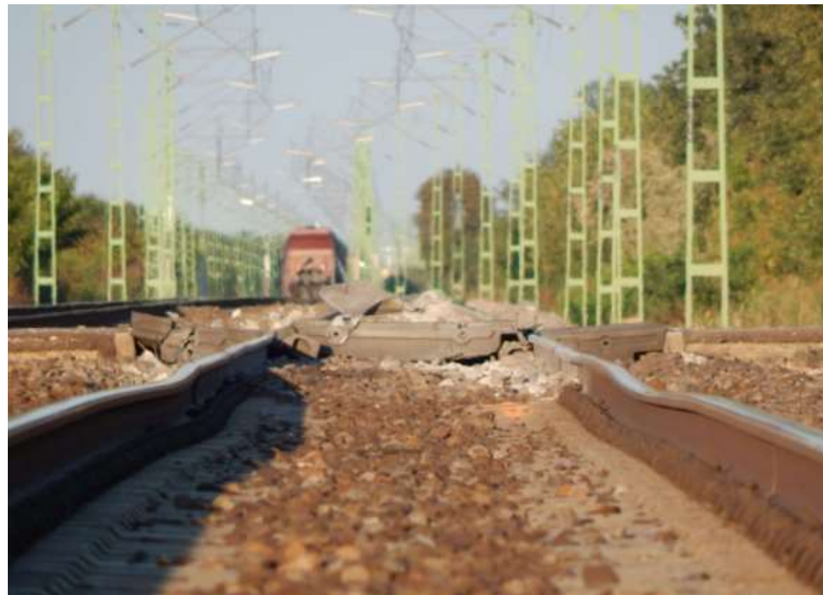
Vágánygeometriai hiba a kisiklás helyét megelőzően
