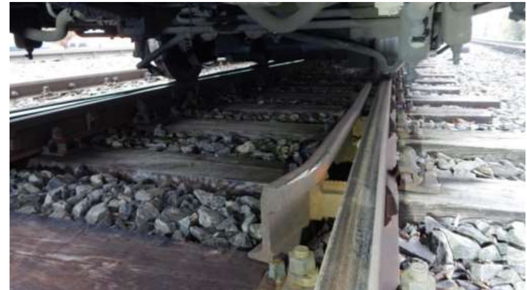
A kitérő vezetősíjnén lévő ütés- és felfutásnyom [36]
