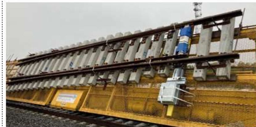
Váltóhajtóművel együtt előszerelt váltó ferde-szállítókoszin
