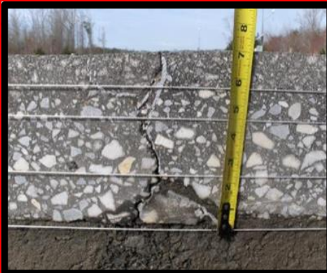
„DOWN – TOP” FÁRADÁSI REPEDÉS
