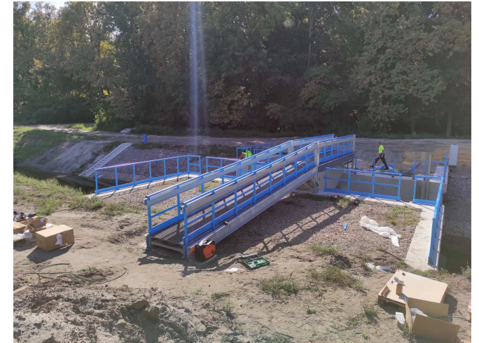
Ős-Dráva projekt 53 műtárgy GRP szerkezeteinek telepítése
