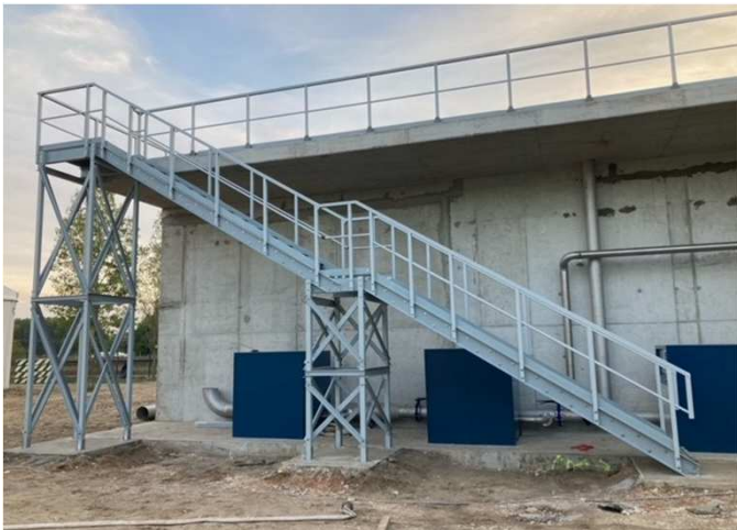
Márka üdítőgyár korlát és lépcsőszerkezet kivitelezése
