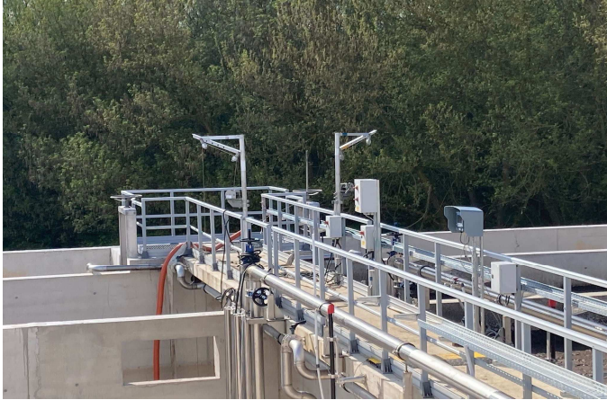
Zalaszentgrót szennyvíztelep korlátrendszer telepítése
