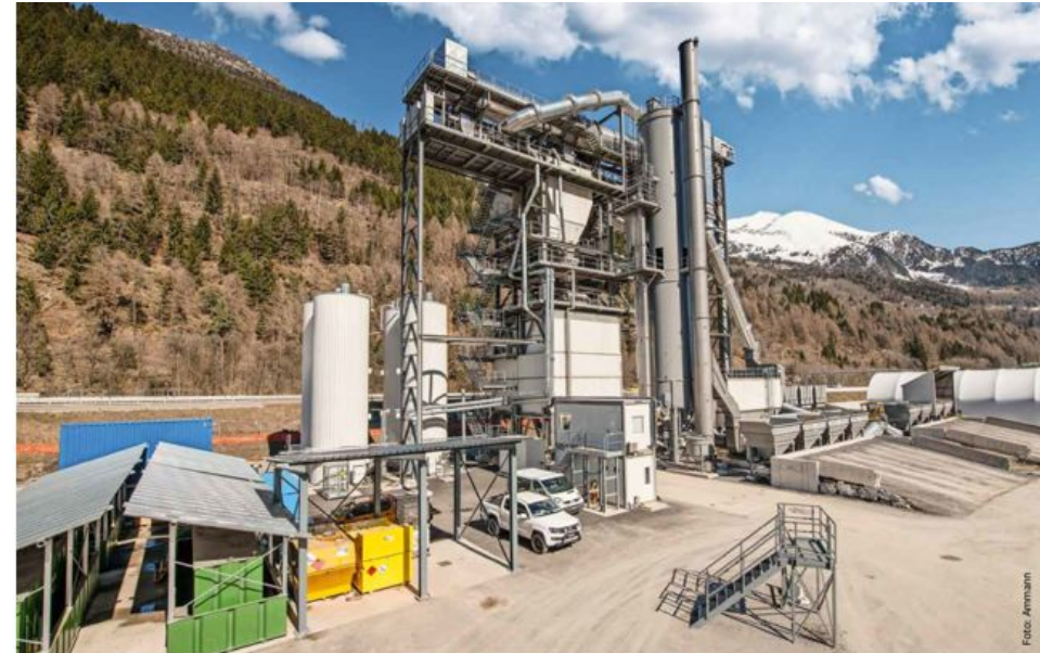
Direkt an der Baustelle werden die Asphalte für die Sanierungsstrecke gemischt
