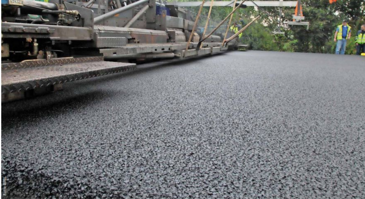
Der Einbau von SMA mit 50 M.-% SMA-Asphaltgranulat mit einem Großfertiger über eine Breite von 11,50 m auf der A 48
