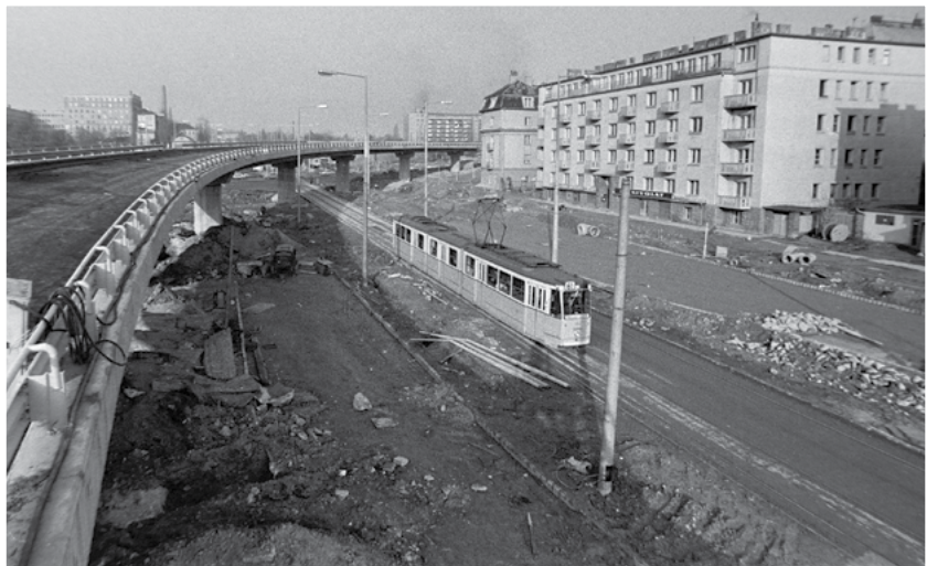
BAH csomópont, a felüljáró építése (1976.), Fortepan 195744 sz. kép / Bojár Sándor
