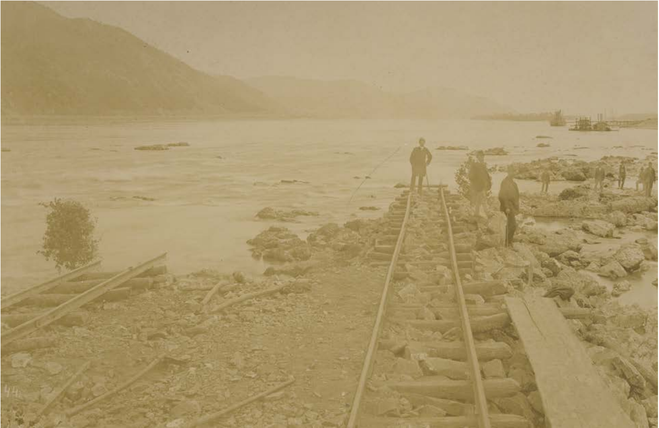
Tájrömböléssel járó közlekedési beruházás a Vaskapu szabályozásánál az 1890-es években (Forrás: MMKM)
